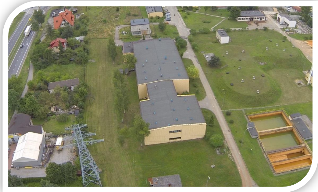
fot. teren Stacji uzdatniania wody w Olkuszu
