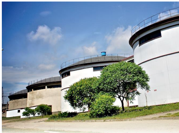
STACJA UZDATNIANIA WODY W OLKUSZU – AKCELATORY.
