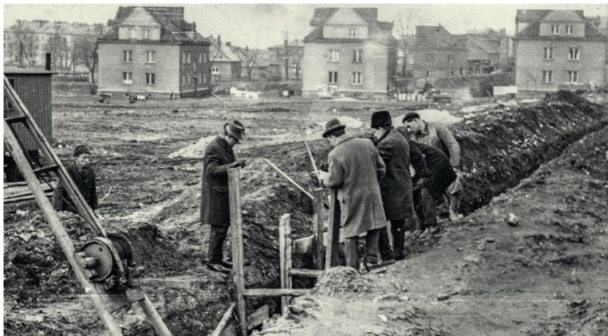
BUDOWA KOLEKTORA SANITARNEGO W OLKUSZU
